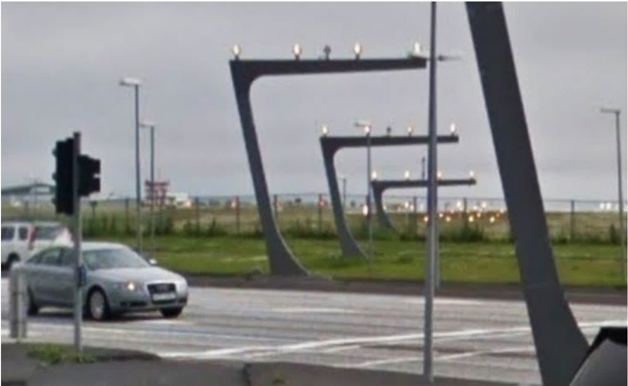
Mynd 2.5 Aðflugsljós norðan Reykjavíkflugvallar. Hér er kveikt á ljósunum og sést að þau lýsa ekki niður á veginn eða í augu ökumanna. Styrkur þeirra er einnig hóflegur og ekki til þess fallinn að valda truflun. Mynd: Google maps.
