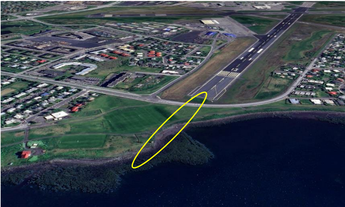
Mynd 3.1 Framkvæmdasvæði við vesturenda flugbrautar. Mynd: Google Earth.
