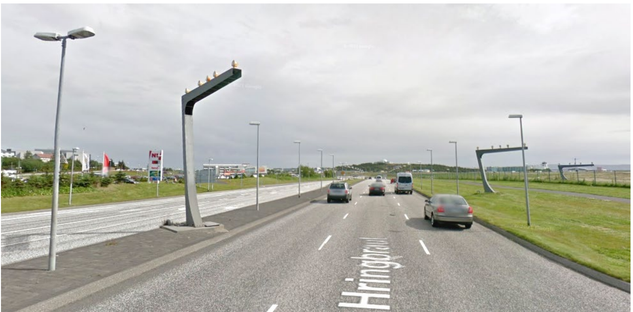
Mynd 2.4 Aðflugsljós norðan Reykjavíkflugvallar sem ná yfir Hringbraut. Mynd: Google maps.
